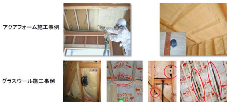
【 図表 3 】 ウレタンフォームとグラスウールの施工事例
